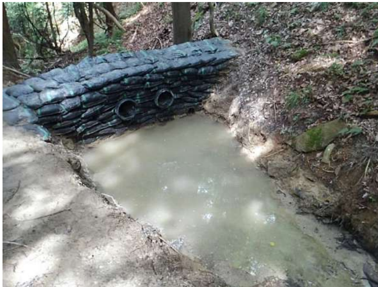
図 3-5 仮設沈砂池の修復後状況写真
