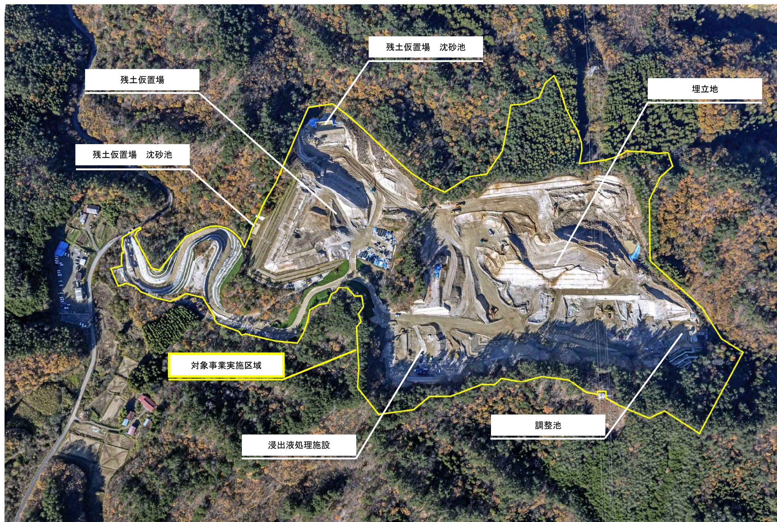
図 2-4 工事実施区域の状況
