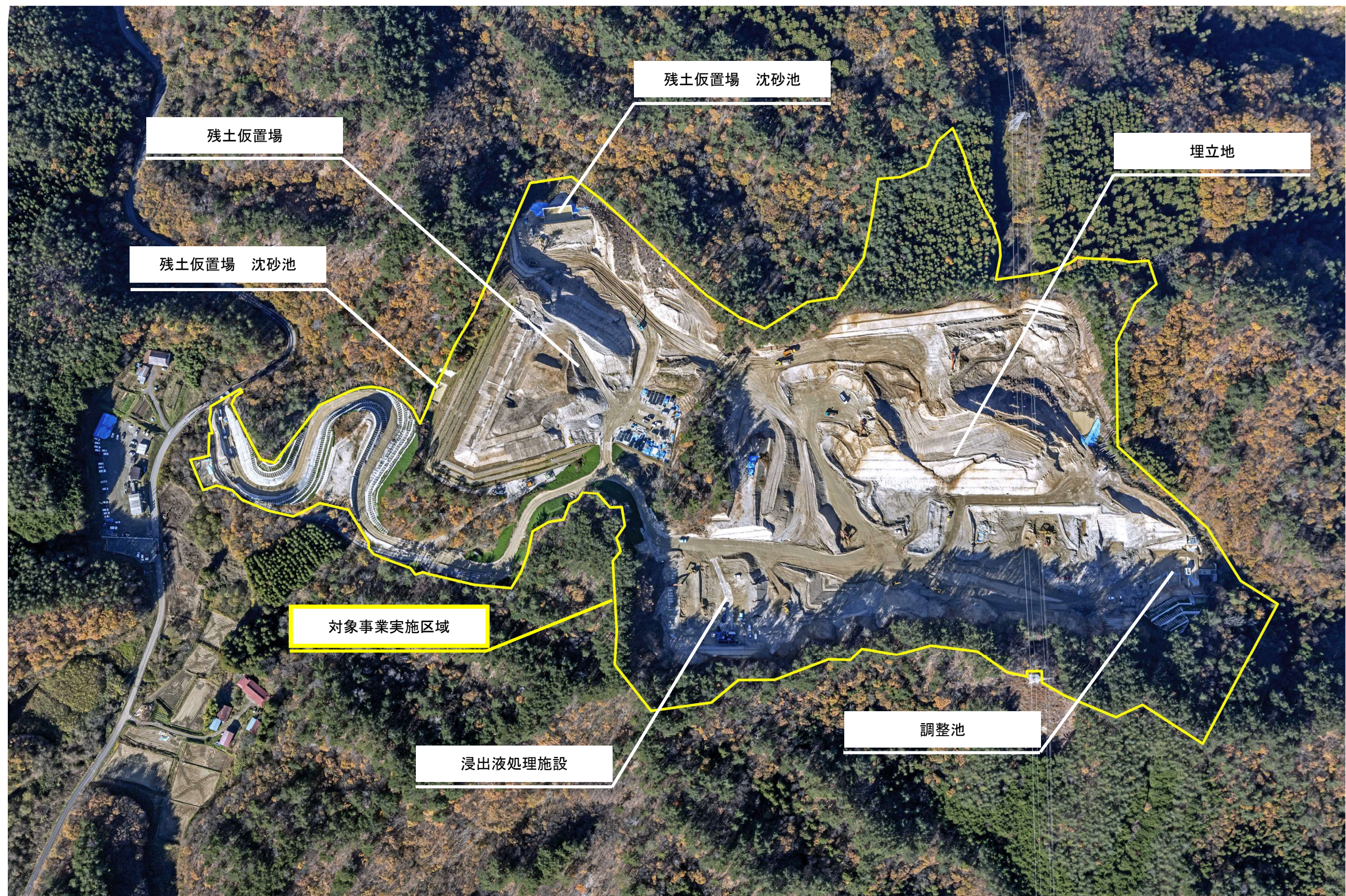
図 2-4 工事実施区域の状況
