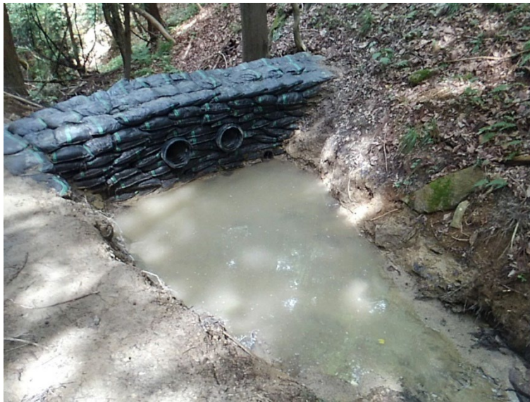
図 3-5 仮設沈砂池の修復後状況写真
